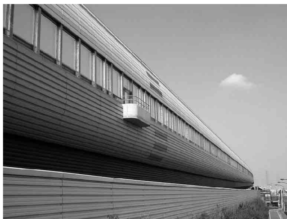
写真1 適用事例 道路遮音材 Photo 1 Application to Noise barrier
